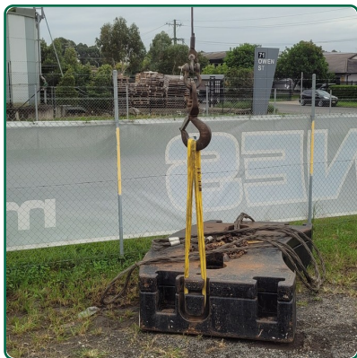
Winch Brake Test
